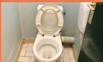
Les sanitaires ne sont pas adaptés aux PMR
