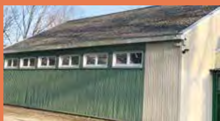
Les toitures sont en fibrociment amianté
